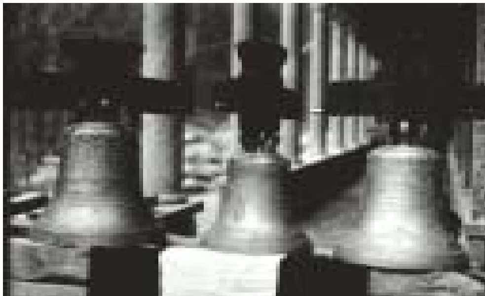
Fig. 42 - 8/11/1936. Le tre campane sono pronte per essere issate sul campanile del Tempio.
