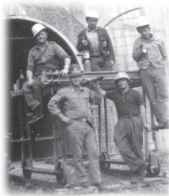
Anni '60. Costruzione galleria dell'oleodotto
