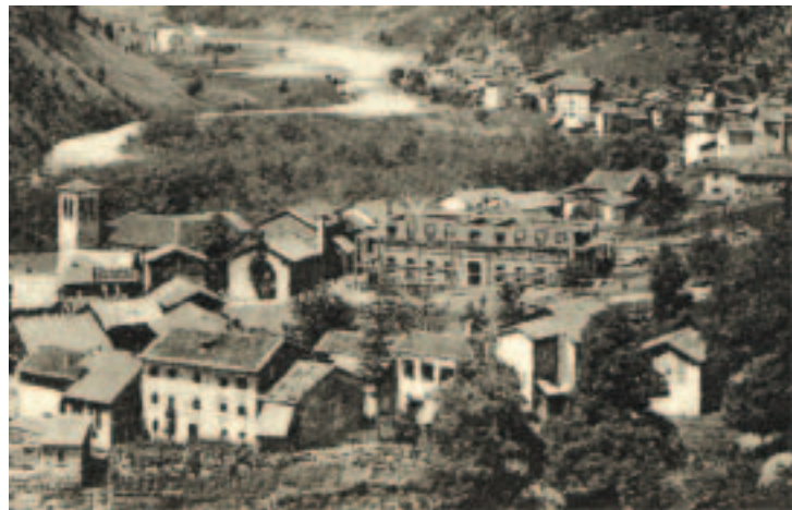
Timau 1910. L'edificio scolastico in costruzione (particolare) Collezione Walter Gozzer
